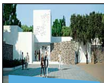
Construcción CESFAM Papudo en marcha blanca
